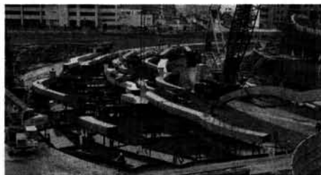
图8 现场主梁拼装与胎架设置示意
