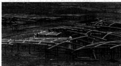
图9 网格梁拼接现场
